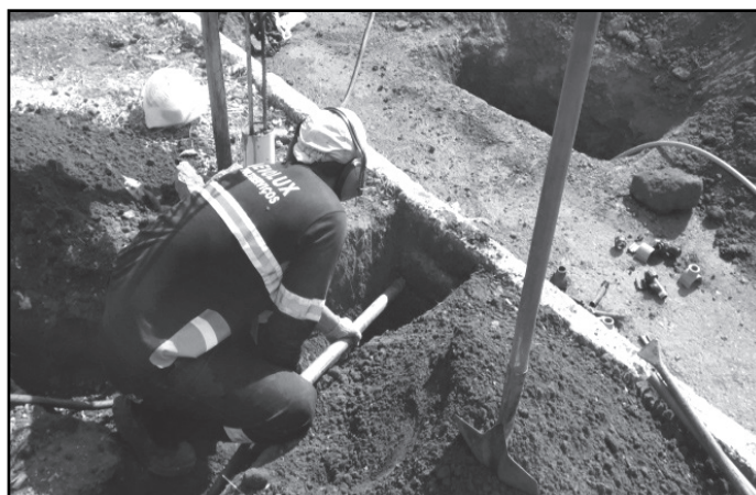
Figura 7 - Encanador lançando haste de perfuratriz, através do furo de sondagem Fonte: Os autores (2015).
