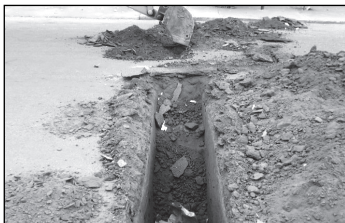
Figura 4 - Abertura de vala com retroescavadeira Fonte: Os autores (2015).
